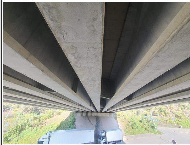
거더 및 가로보 전경
